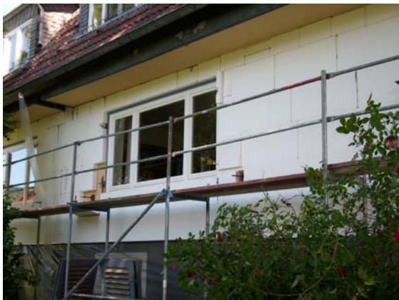
Haus Am Hutekamp 1 Dämmung Nordseite
