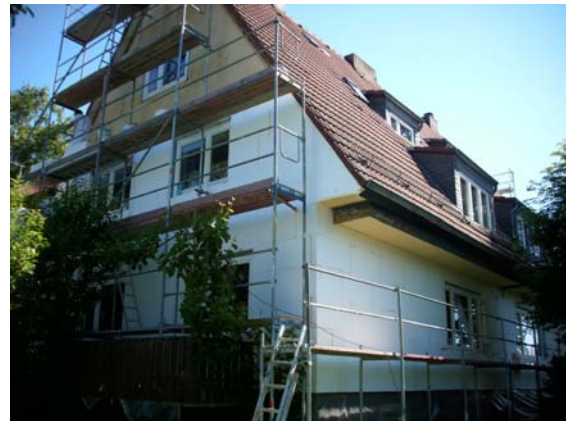
Haus Am Hutekamp 3 Dämmung Giebel
