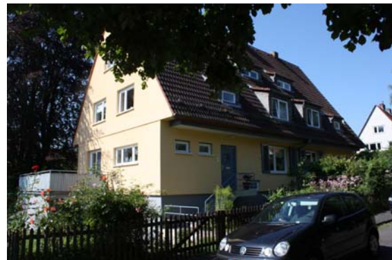
Haus Hutekamp 1/3 nach Fertigstellung 2009
